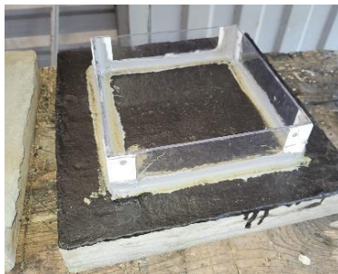
Figura 7 - Laje Impermeabilizado com Manta Asfáltica.
