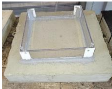
Figura 6 - Laje Impermeabilizado com Argamassa Polimérica.
